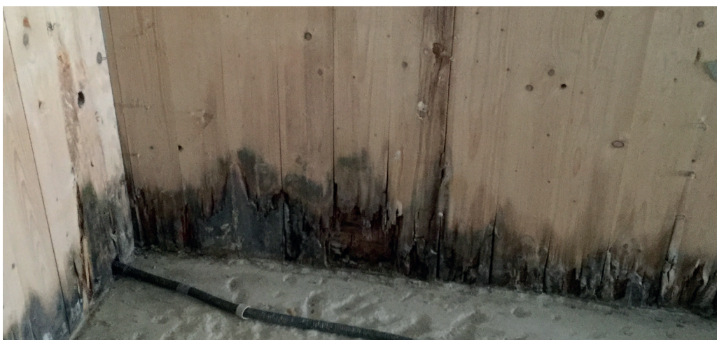
Esempi di marcescenza del legno nel punto di attacco a terra
